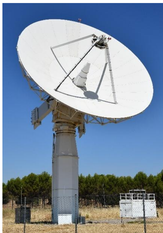
Ilustración 9. Antena TRN-1 para bandas S y X en el Centro Espacial INTA-Torrejón (CEIT).
